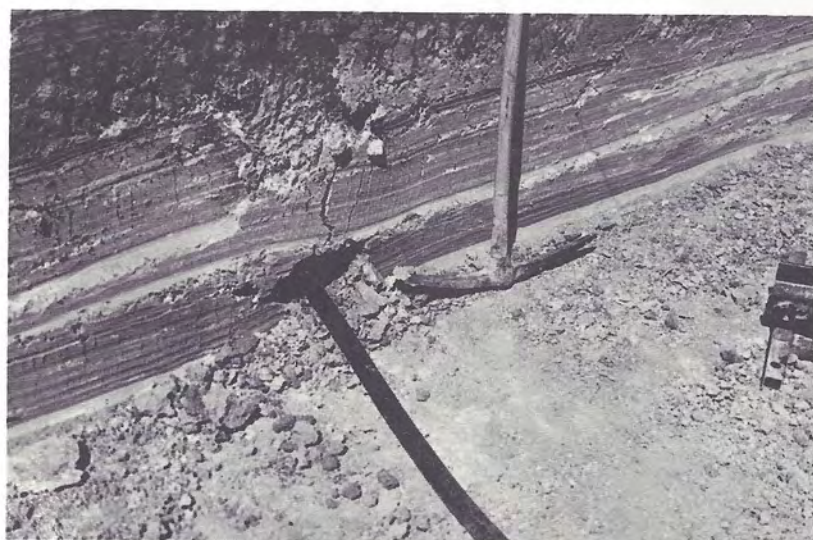
El topo neumático, colocado, empezando a penetrar en la tierra.
