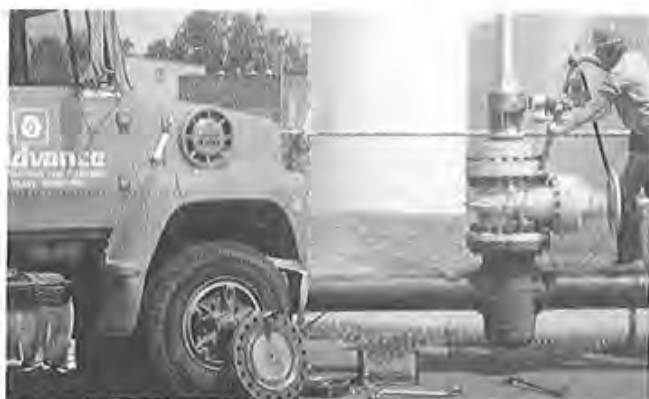
Colocación de un aparato especial de la casa Advance para marginar una tubería y colocar en ella una válvula.
