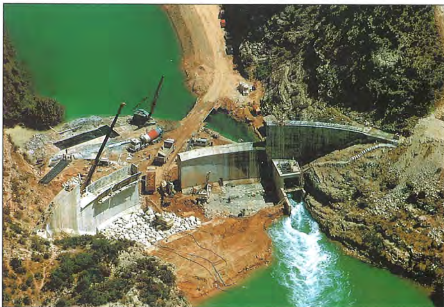
Presa de El Duende, en construcción.
