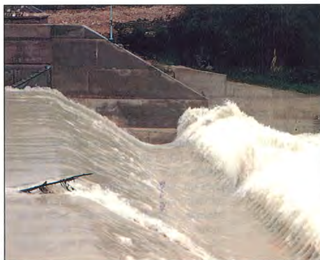
Funcionamiento de la presa de Encarroz durante la avenida de enero
