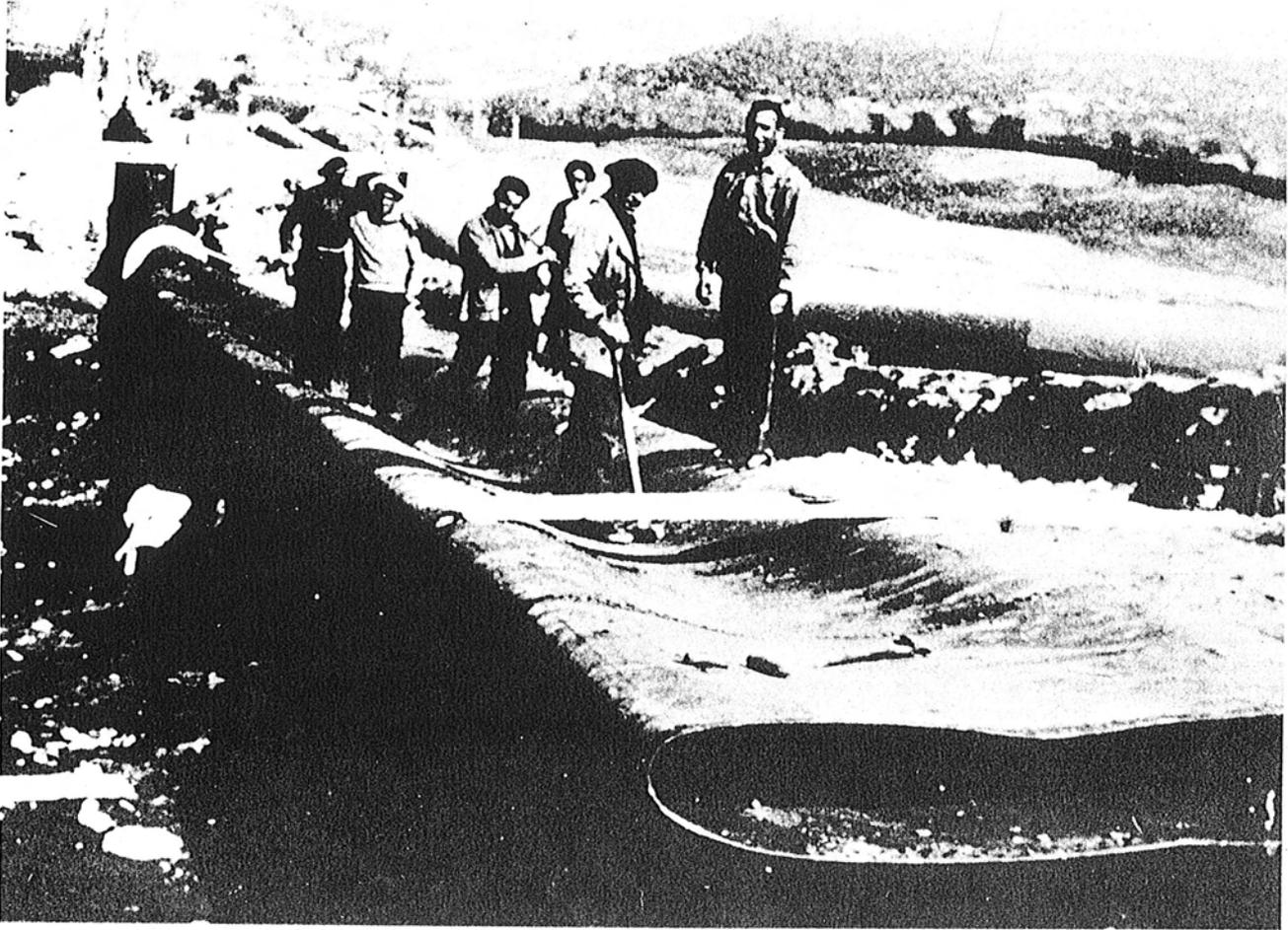
Tubería de 1500mm aplastada al abrir un desagüe y no existir ventosas.
