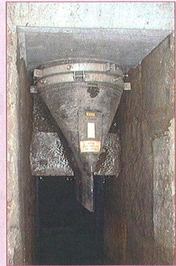
Figura 3. Válvula instalada con el detalle de los flejes.
