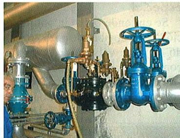
Foto 1. Instalación de alivio de presión mínima en una instalación de bombeo.
