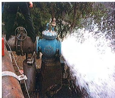
Foto 4. Válvula de alivio para evitar las sobrepresiones causadas por el golpe de ariete.
