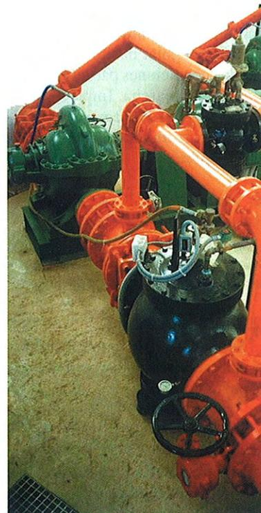
Foto 5. Estación de bombeo que incluye una válvula optimizadora y una de alivio Ross.
