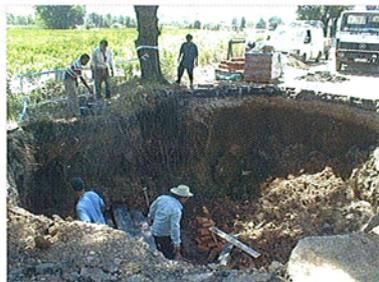
Figura 2. Efecto de una rotura de una tubería. La selección de las válvulas no se debe de hacer basándose sólo en el coste de compra, pues suponen una parte insignificante del coste total de la obra y pueden aumentar el coste del mantenimiento.
