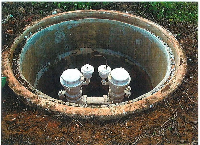
Foto 3. Instalación con dos ventosas y sus purgadores para evacuar tanto el aire al poner en marcha la instalación como el aire a presión.
