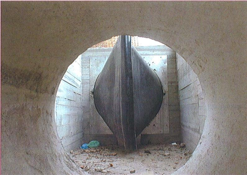
Figura 2. Válvula de gran diámetro con los labios en línea recta.
