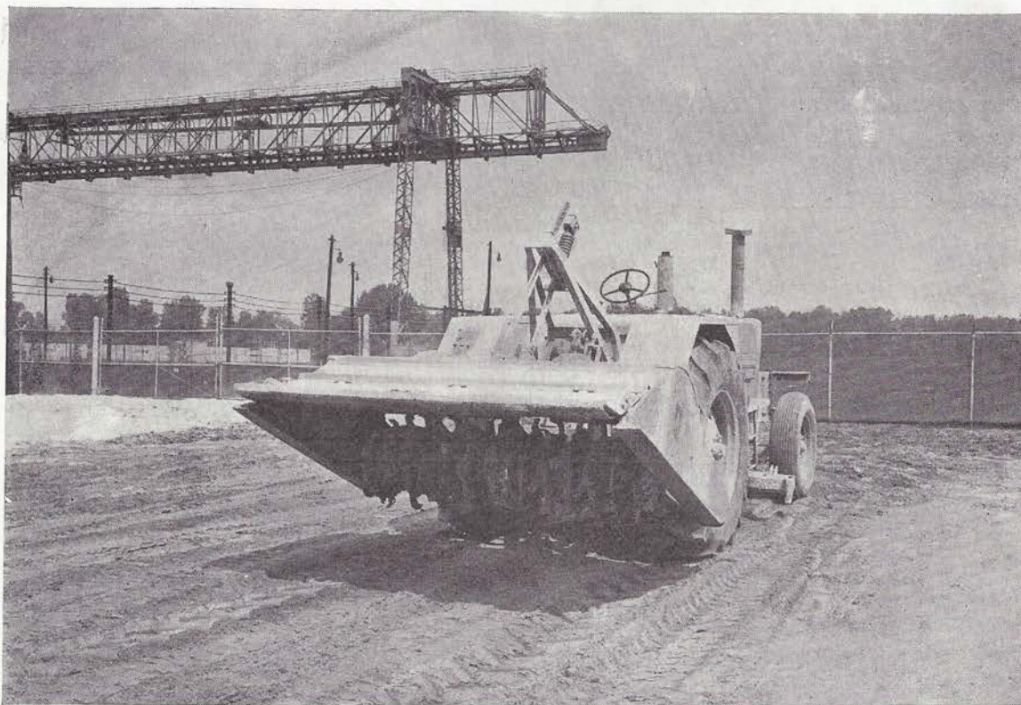
Vista de una mezcladora de tránsito tipo "pulvinizer".
