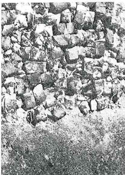
Base para pavimento de una calle, hecha de ladrillos partidos.
