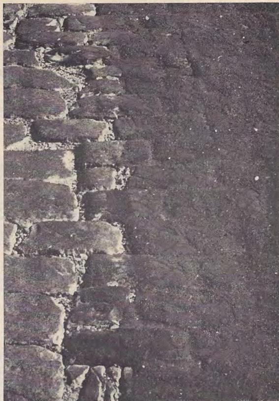
**LA CARRETERA** Toledo-Madrid en sus tramos adoquinados será tratada con el "slurry". La emulsión asfáltica ofrece una solución económica.
