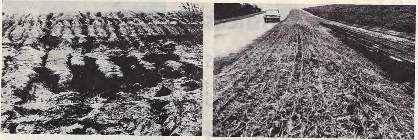
(Izquierda) Talud seriamente dañado por la erosión. (Derecha) Estabilización de un talud por siembra para prevenir la erosión. La paja protege hasta que crezca la hierba. (Fotos cortesía de la Iowa Highway Commission).
