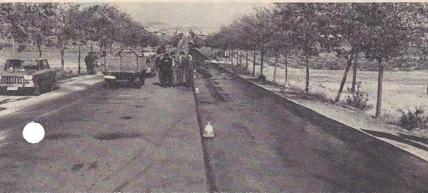
**ARRIBA**, un distribuidor-alisador mecánico acoplado a la mezcladora de flujo continuo, brinda un acabado perfecto evitando pérdidas de material. **ABAJO**, la mitad de un pavimento tratado contrasta con la calzada aún sin regenerar.
