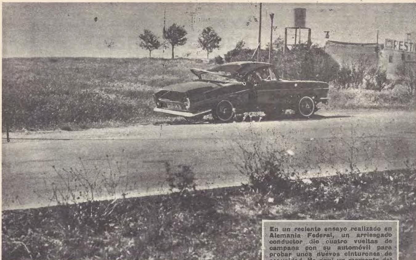
En un reciente ensayo realizado en Alemania Federal, un arriesgado conductor dio cuatro vueltas de campana con su automóvil para probar unos nuevos cinturones de seguridad. He aquí un momento del accidente provocado y el chófer haciendo fijas del vehículo.
