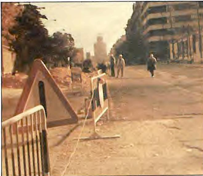
◀ Otro ejemplo de vallas colocadas de perfil para favorecer los accidentes, incluida la colocación de señales al azar.
