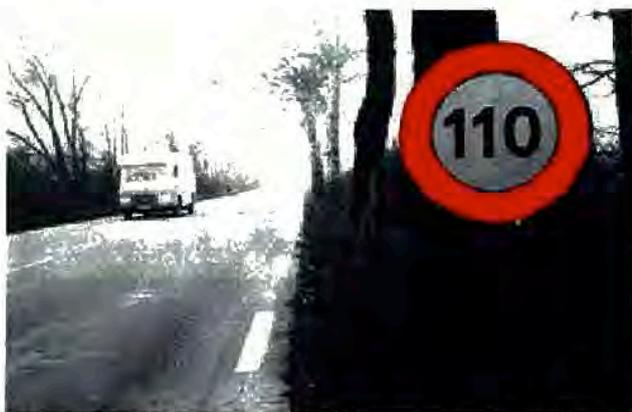
La velocidad máxima en esta carretera debería ser de 70 kms/h., debido a los siguientes factores: pavimento en mal estado, calzada estrecha, existencia de árboles y obstrucciones junto a la calzada, arcén (donde lo había) irregular y con hoyos y zanjas. Como se puede ver indicaban 110 kms/h. de velocidad máxima.
