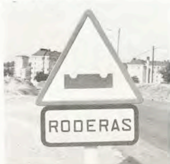
Fig. 3.—Prototipo de la nueva señal para advertir el peligro de rodadas. El cartel dice «rodadas».
