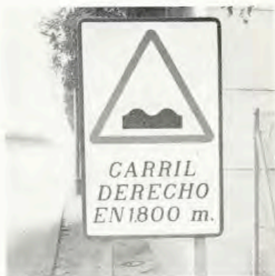
Fig. 2.—Adaptación de la señal de badén para advertir la existencia de rodadas.
