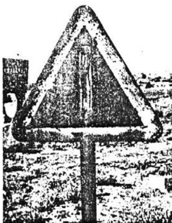
Fig. 1.—Señal oxidada, junto al mar, hecha de chapa de acero. Este material se suele exigir por falta de información sobre las propiedades del PRFV.
