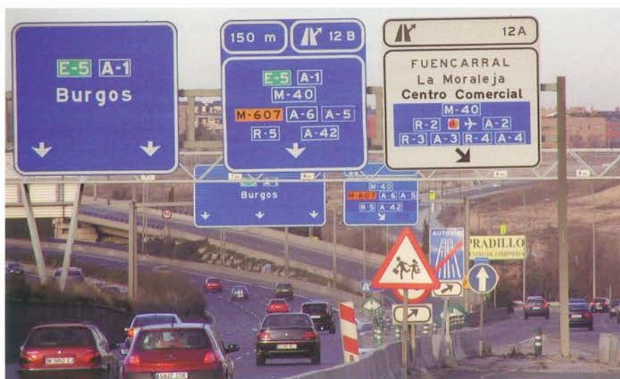
FOTOGRAFÍA 5: Este es un ejemplo de información que abruma al conductor causándole ansiedad. La señal de niños saliendo de una escuela no se comprende, pues nunca hubo escuelas y está en una autopista. Estaba durante unas obras. La señalización actual sigue sobrecargada.
