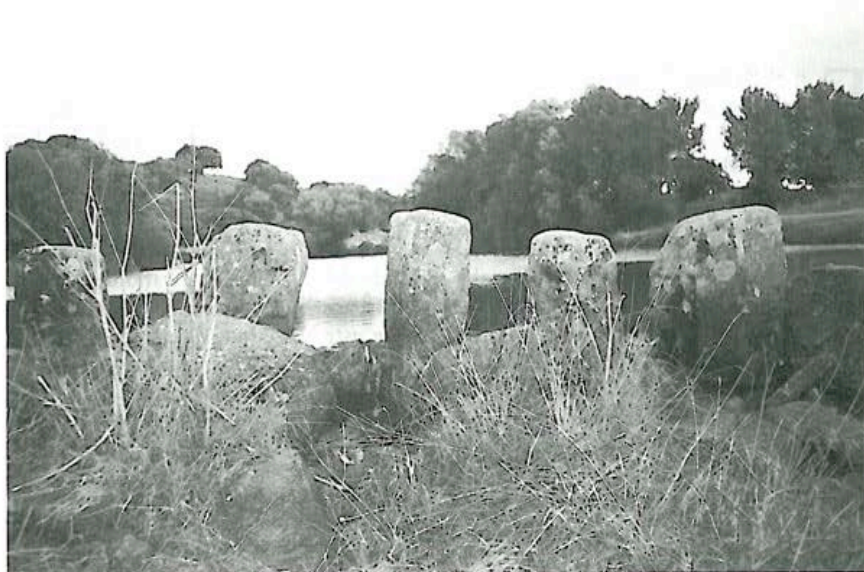
Paso por un vado del río Yeltes, llamado de "pantones", usado por el autor en numerosas ocasiones, que conecta con otro igual en el río Huebra, a unos dos km. Estos vados fueron sustituidos por puentes de piedra cuando la mano de obra era barata en España y no se empleaba maquinaria. En países donde la mano de obra es barata, o basada en la llamada prestación personal, hay que empezar analizando la posibilidad de hacerlos de piedra.
