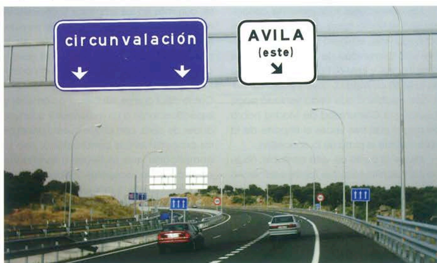
FOTOGRAFÍA 2: Una solución que se entiende mejor es sustituir el cartel de la izquierda por otro más pequeño y poner solamente la palabra "circunvalación"; aunque las flechas no son necesarias, se pueden dejar. Con esta solución se economiza en el tamaño de los cartelones, con un pórtico menos resistente. Al presentar la información de una manera más sencilla se origina menos estrés al conductor.
